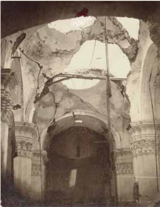
Iglesia del Carmen Alto. 1874, después del terremoto de 1868. Quito, Ecuador. Fuente: Colección Alphonse Stübel. Instituto Metropolitano de Patrimonio del Municipio Metropolitano de Quito. Fondo de Fotografía de y sobre Quito y Ecuador en el Instituto de Geografía de Leipzig, Alemania
