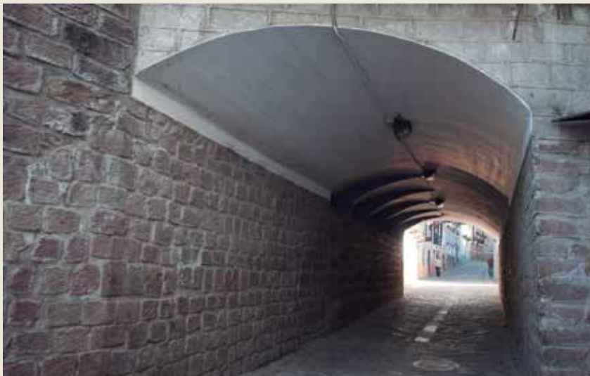
El "túnel" es la única estructura que se conserva de la obra original de Reed referida al antiguo puente y túnel de La Paz, pues medio siglo después del relleno de la quebrada, la Municipalidad realizó una obra vial de envergadura, para crear una conexión este-oeste, al sur del Centro Histórico. Fuente: Fotografía del autor.
