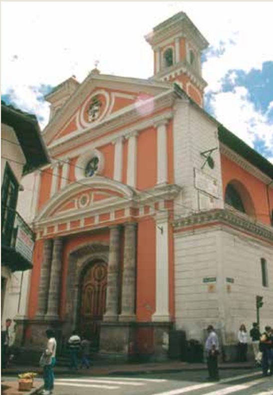
Iglesia de Santa Catalina, Quito, estado actual. Fotografía: Alberto Saldarriaga Roa.
