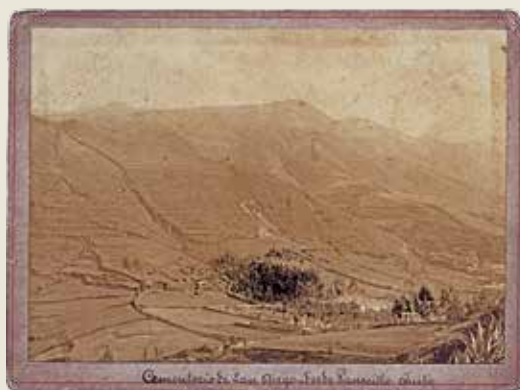
Vista del Pichincha desde el sur, con el incipiente desarrollo del cementerio de San Diego, junto al bosque de eucaliptos de la recoleta franciscana del mismo nombre. Anónimo. Ca. 1900-1910. Fuente: Archivo histórico Camilo Destruge, Municipio de Guayaquil. Instituto Nacional de Patrimonio Cultural/Archivo Nacional de Fotografía.
